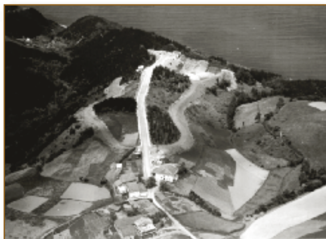
Vista aérea obtenida por Paisajes Españoles S.A. de las zonas que componían entonces en núcleo rural de los Usarraga y del camping de Itsaspe. Año 1969. AMD.
