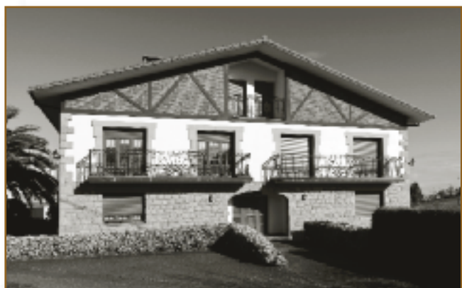
Vista de la fachada principal de Usarraga Beña. Enero 2020.
