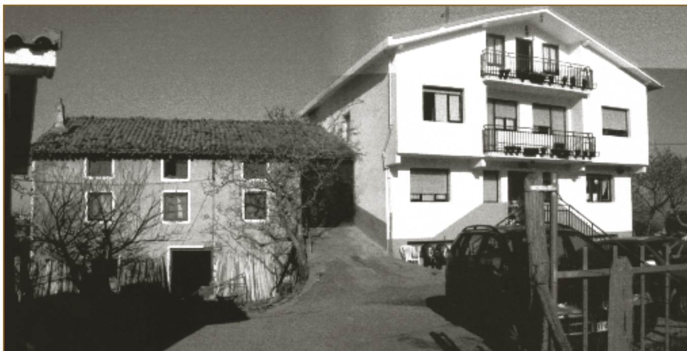
Vista de Usarraga Haundi, parte reconstruido y la antigua, después también derribada y construido de nuevo con el nombre de Zahar. AMD. 2004.
